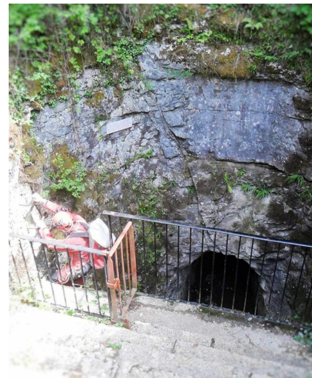
L'entrée du tunnel d'assèchement de la vallée de Drom-Ramasse (Photo AGEK)
